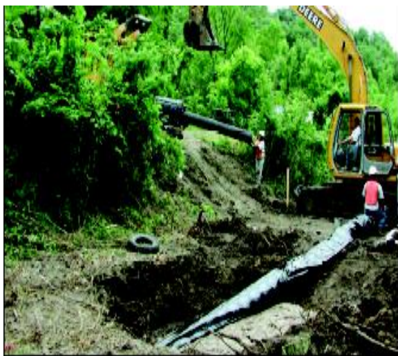
Рисунок 6.24 Картриджный метод укладки труб.
