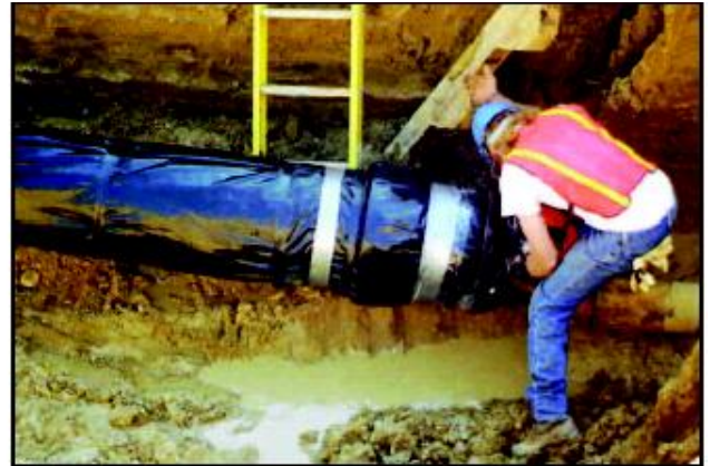
Рисунок 6.22 Покрытие труб полиэтиленовым рукавом.
