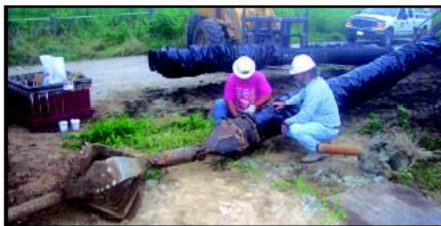
Рисунок 6.17 Прокладка трубопровода методом горизонтально направленного бурения.
