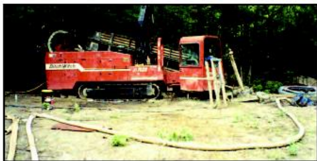
Рисунок 6.17 Прокладка трубопровода методом горизонтально направленного бурения.
