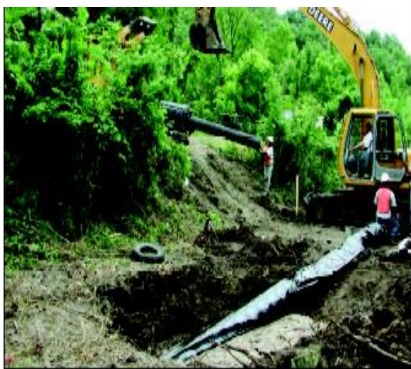
Рисунок 6.24 Картриджный метод укладки труб.
