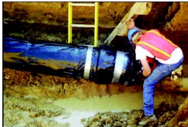
Рисунок 6.22 Покрытие труб полиэтиленовым рукавом.
