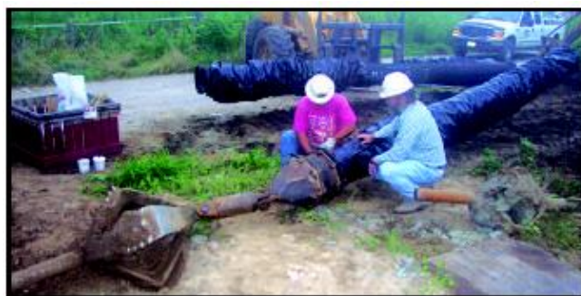
Рисунок 6.17 Прокладка трубопровода методом горизонтально направленного бурения.
